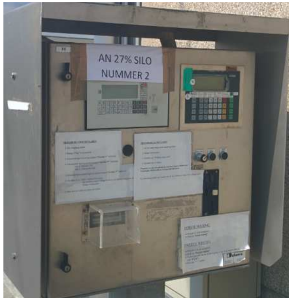
Figuur 2: Bedieningskast voor de landbouwer met linksboven de bedieningsdisplay.
