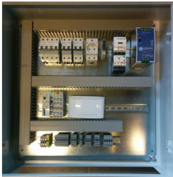
Figuur 26: De installatiekast bij de silo's klaar om aan te sluiten..
