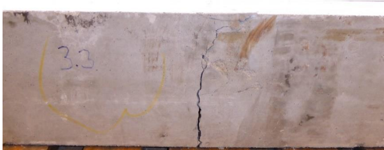
Figuur 29: Schadepatroon proefstuk van samenstelling 3
