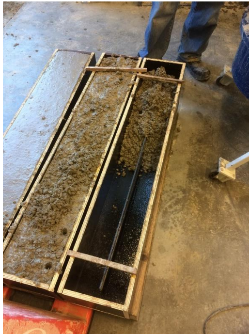
Figuur 10: Het vullen van de mallen
