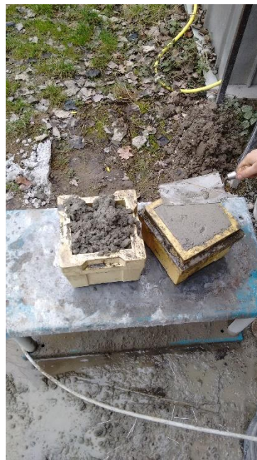
Figuur 11: Het verdichten van de kubussen
