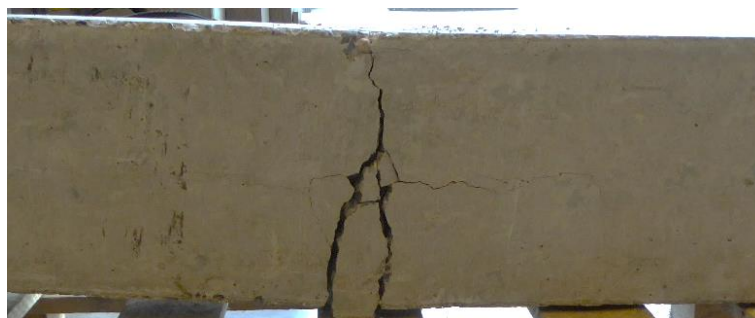
Figuur 27: Schadepatroon proefstuk van samenstelling 1
