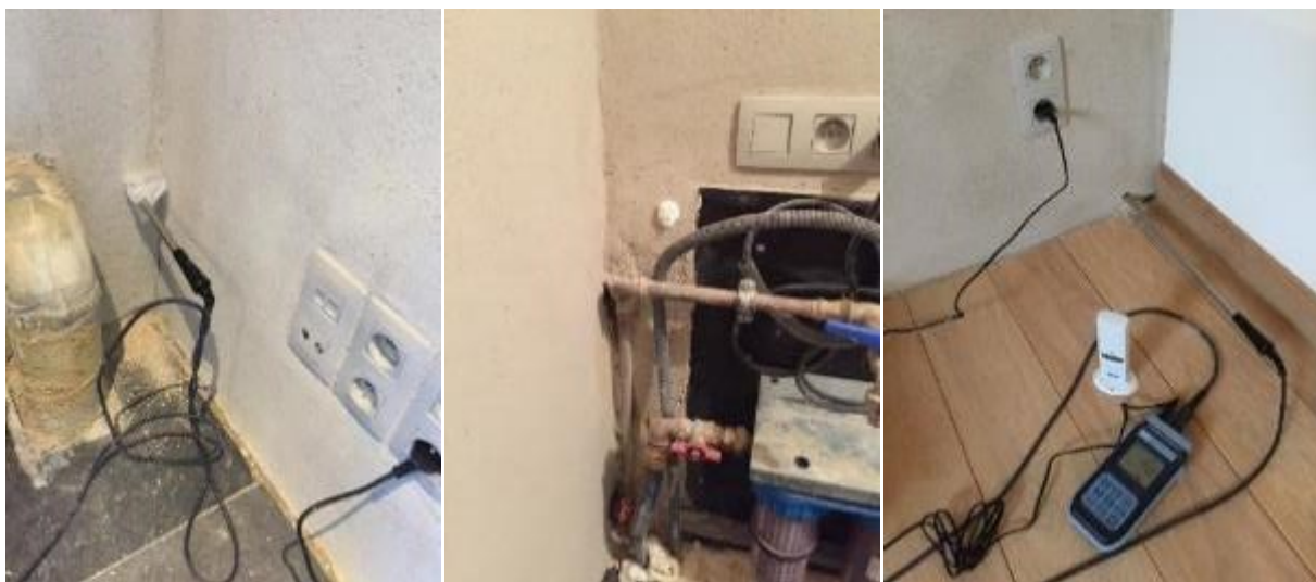
Figuur 50: Locatie A, B en C (van links naar rechts) binnen verbouwing 1
