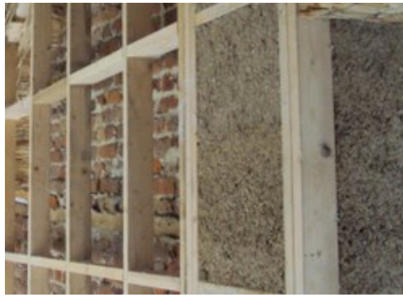
Figuur 2: Kalkhennep als binnenisolatie [15]
