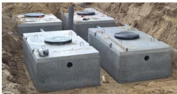
Figuur 19: Infiltratiemodule uit poreus beton [12]
