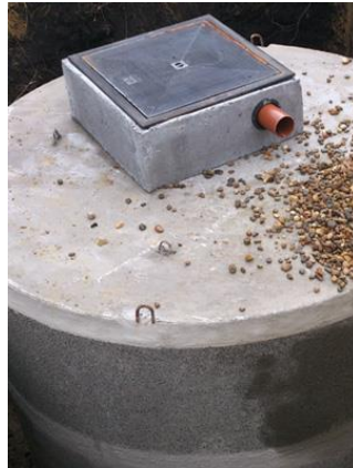
Figuur 18: Combinatieput infiltratie-hemelwater [7]
