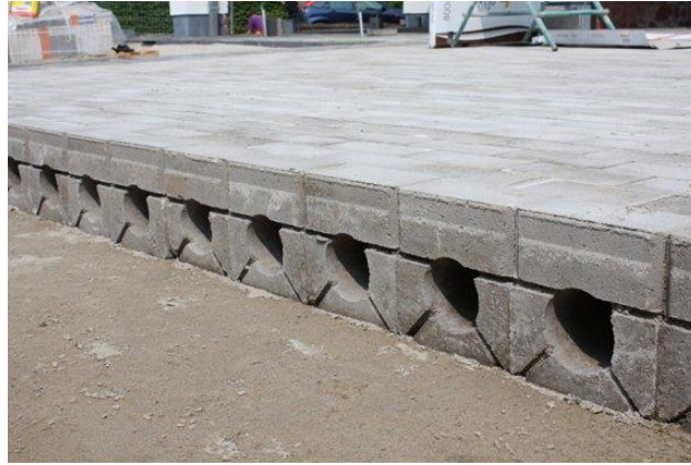
Figuur 31: Fluvio-blokken als toplaag [1]
