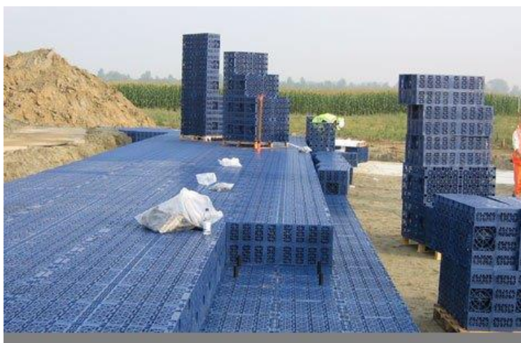
Figuur 20: Infiltratiekratten [28]
