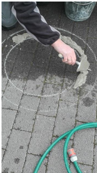
Figuur 48: Aanbrengen van de cementmortel op de krijtmarkeringen
