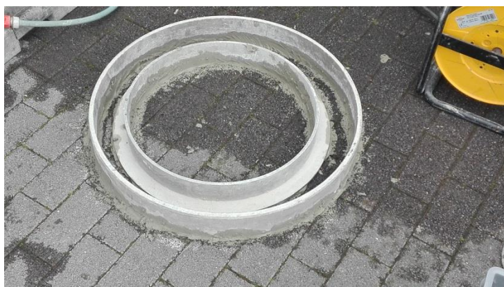
Figuur 49: Aanhechting van de binnenste en buitenste ring met het bestratingsoppervlak
