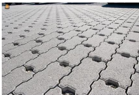
Figuur 8: Betonstraatstenen met verbrede voegen [21]
