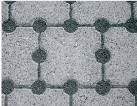
Figuur 7: Betonstraatstenen met drainageopeningen [13]
