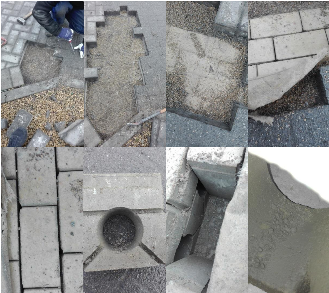
Figuur 54: Het opgebroken systeem in Heusden-Zolder
