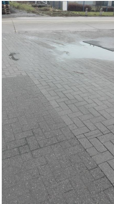
Figuur 55: Vergelijking toplaag met verschillende onderbouw
