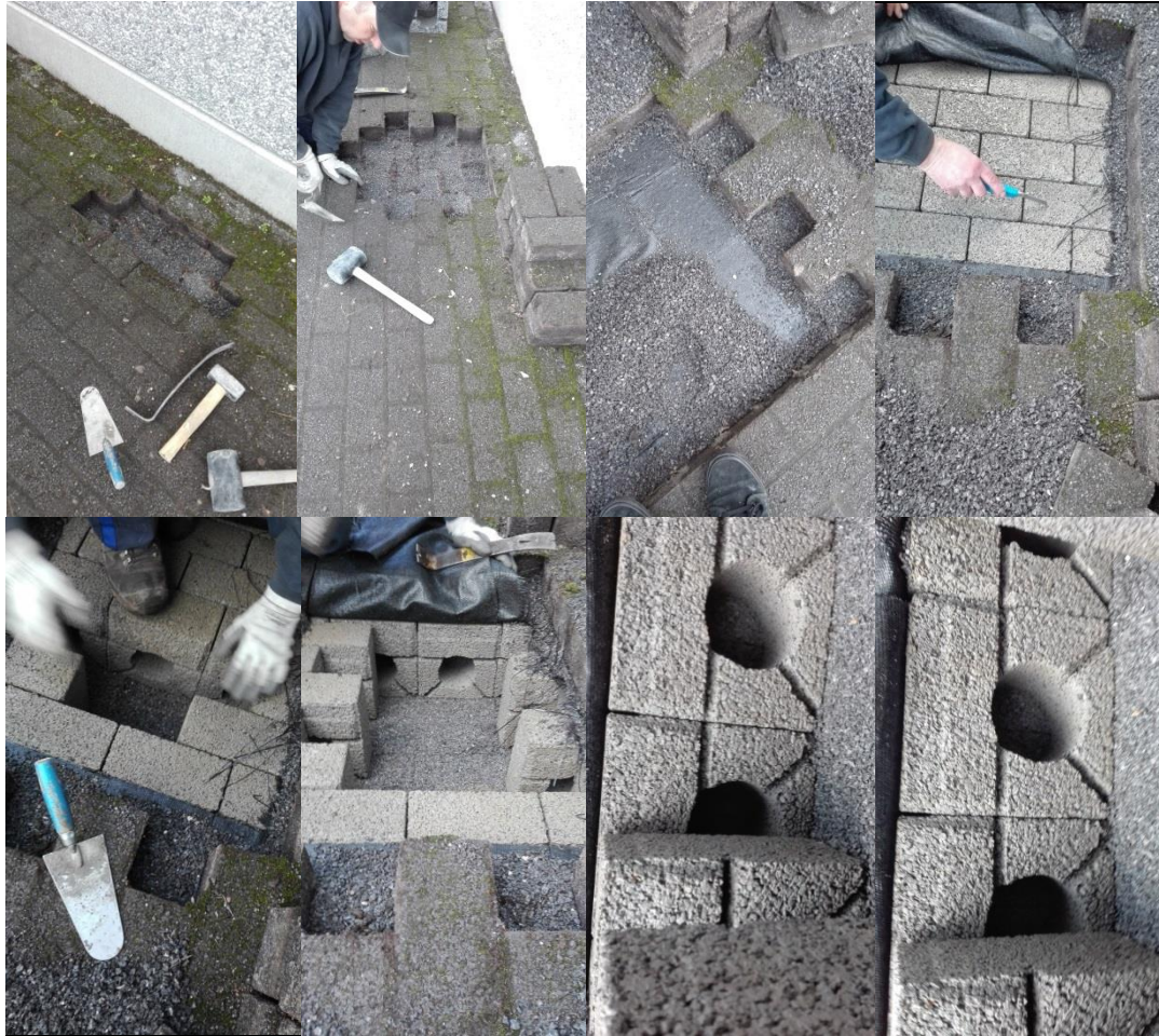
Figuur 55: Het opengebroken systeem in Dessel
