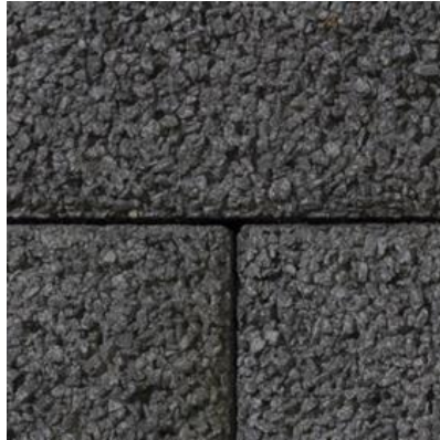
Figuur 9: Poreuze betonstraatstenen [23]
