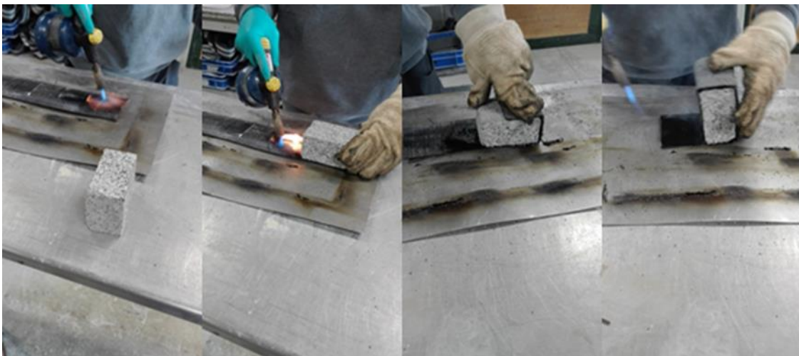
Figuur 40: Proces van het omdoen van de roofingband
