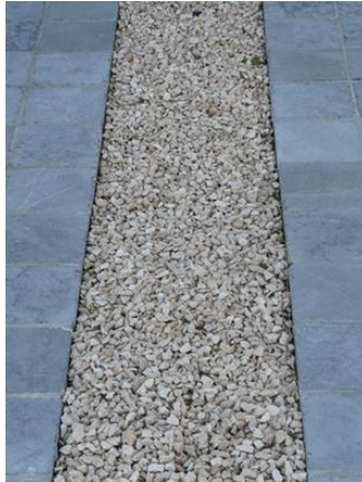
Figuur 15: Infiltratiesleuf [7]
