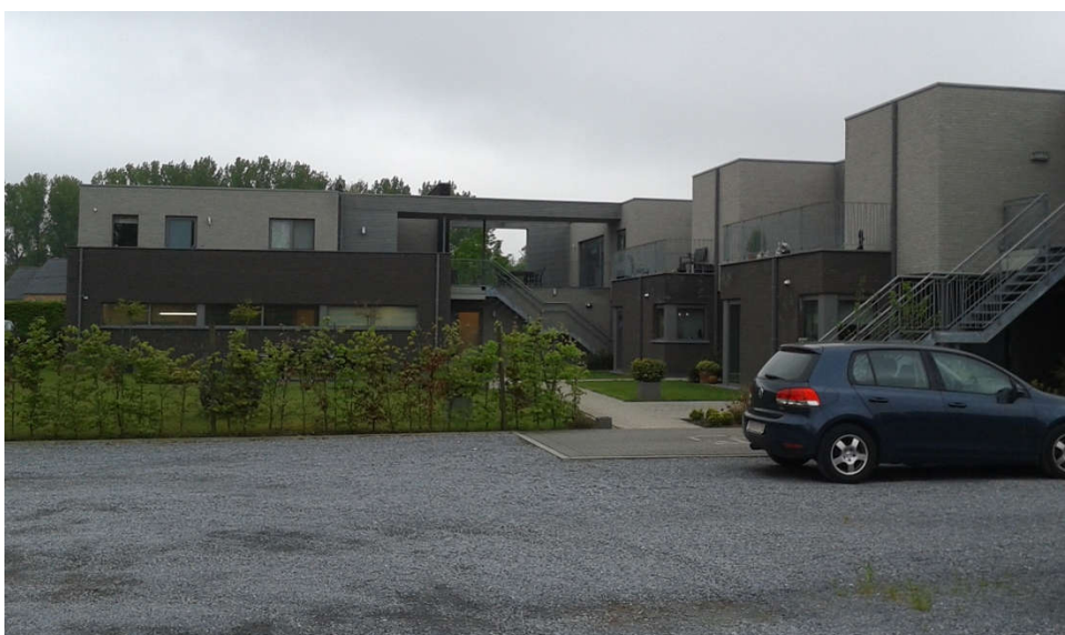
Figuur 51 Gevel woonzorgcentrum Hortensia
