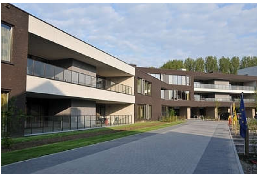
Figuur 11 Gevel woonzorgcentrum Demerhof [23]
