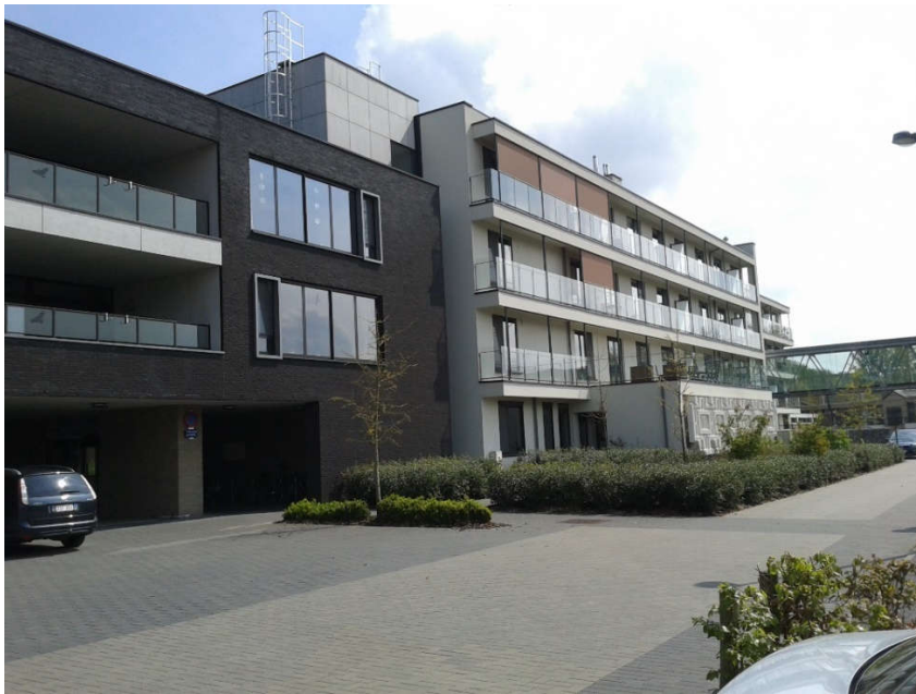
Figuur 13 Demerhof blok B (links) en De Wissel serviceflats (rechts)
