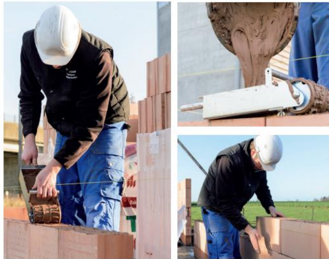
Figuur 3: POROTHERM Lijm-systeem met rolbak [6]
