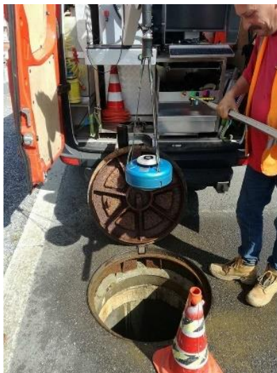
Figuur 17: Putinspecties met putpanoramo-systeem
