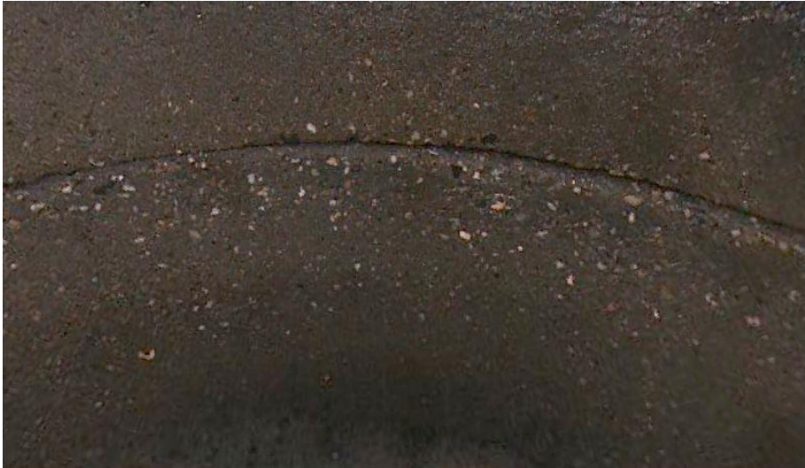
Figuur 21: QS22722605 - granulaten zichtbaar
