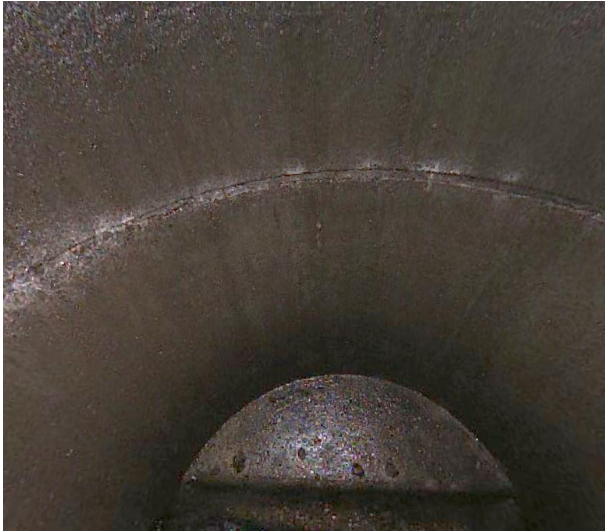
Figuur 19: Inspectieput QS07675007 - geen aantasting zichtbaar
