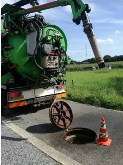
Figuur 18: Reiniging van de inspectieput
