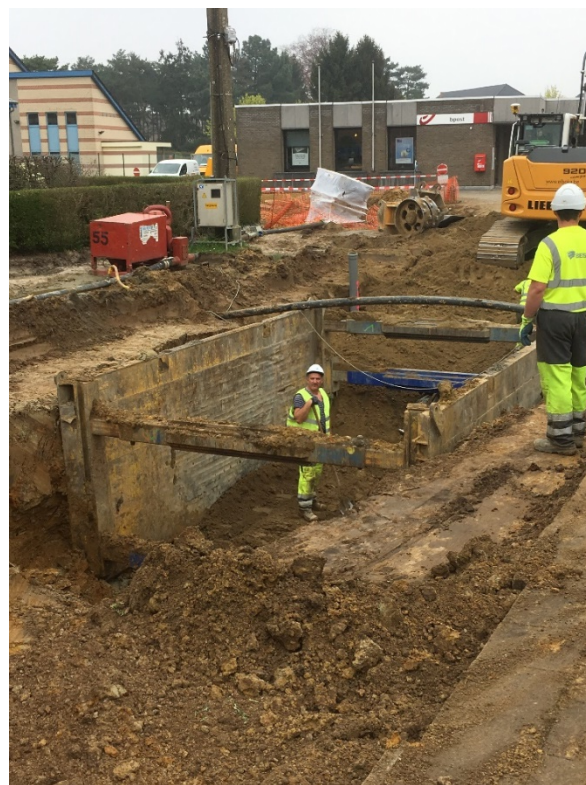
Figuur 26: Aanleggen van de riolering doormiddel van een sleufbekisting
