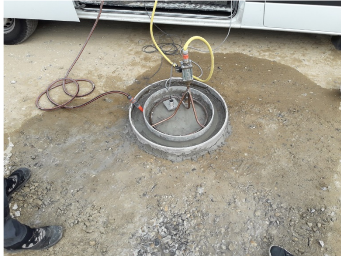
Figuur 39: Uitvoering infiltratieproef
