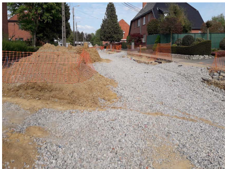
Figuur 44: Betonpuin 20/63 vervuild met leem (week 1)
