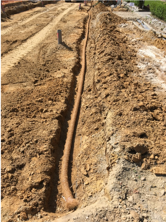
Figuur 29: Aanleg drainage in de aardebaan
