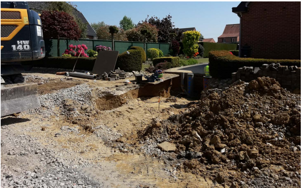
Figuur 47: Aansluiten riolering aangelanden (week 2)
