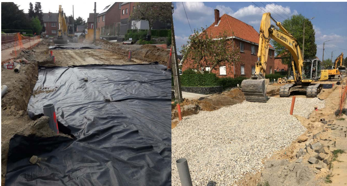
Figuur 34: Proefvak met en zonder geotextiel
