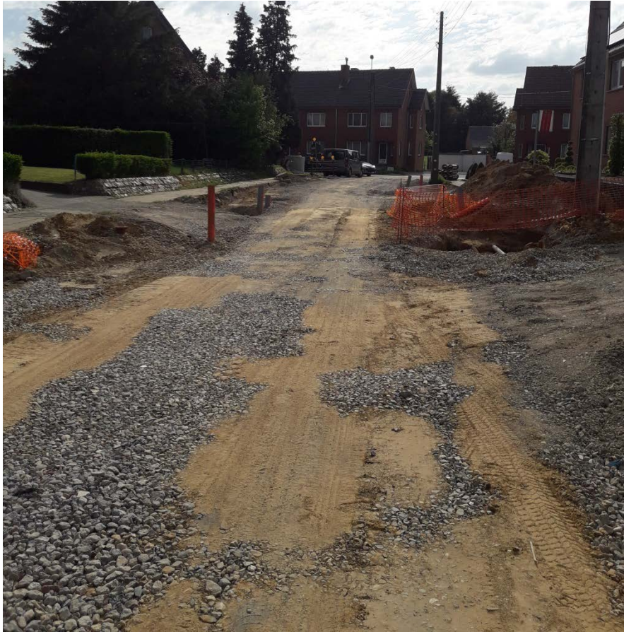
Figuur 45: Silexsteen vervuild met leem (week 1)
