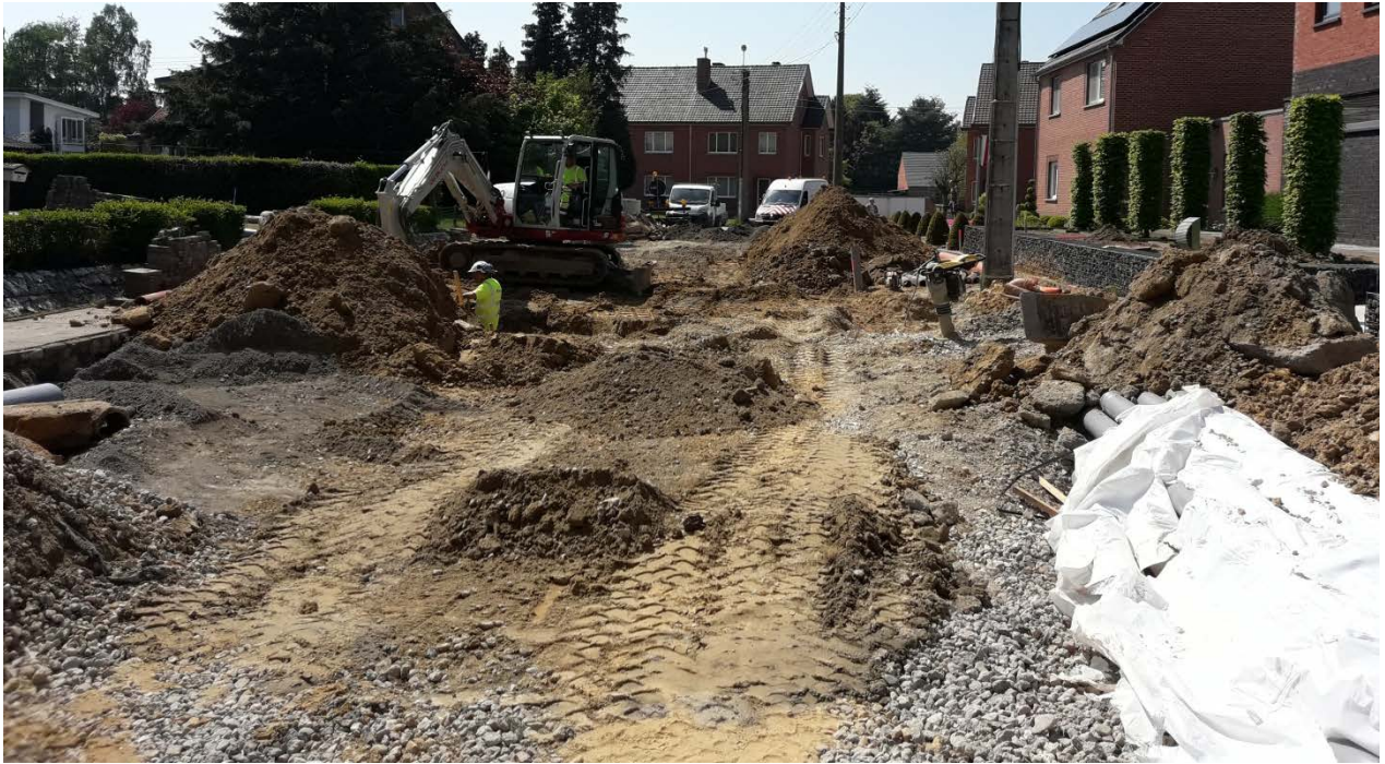
Figuur 46: Proefvakken tijdens rioleringswerken (week 2)
