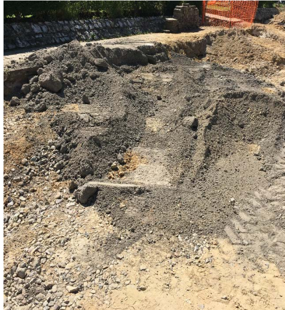
Figuur 48: Stabilisé gebruikt tijdens rioleringsaansluitingen aangelanden
