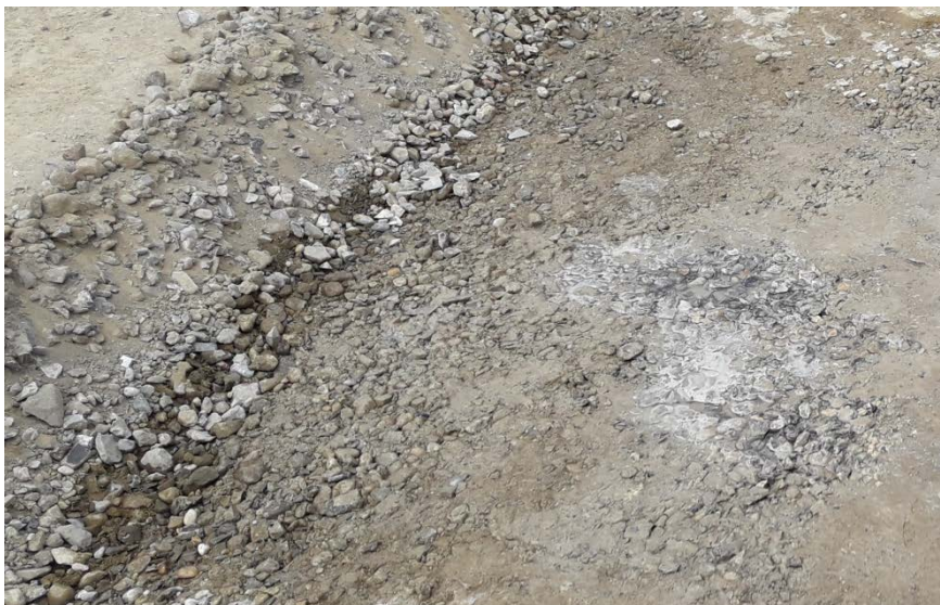
Figuur 52: Proefvakken met leemgrond en drainage als ondergrond
