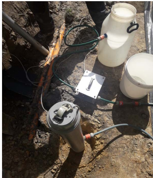
Figuur 37: Uitvoeren van de open-end test
