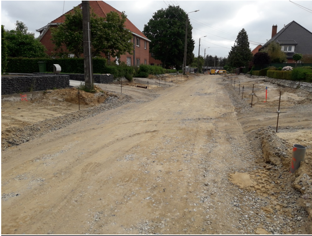
Figuur 49: Steenslag na dichtgraven aansluitingen aangelanden (week 3)
