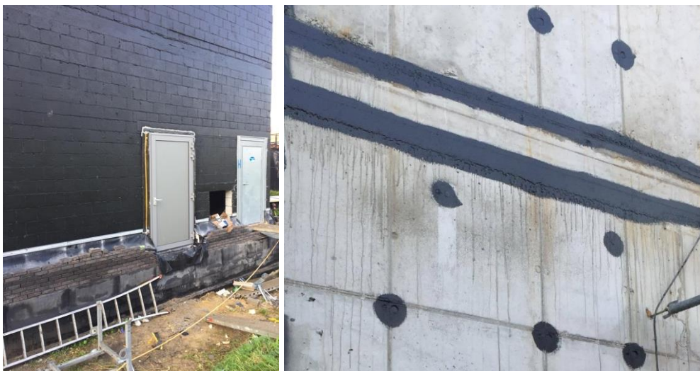
Figuur 18: Toepassing Blowerproof Liquid op betonstenen en ter plaatse gestort beton
