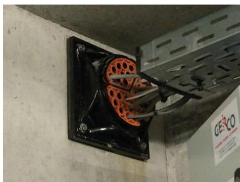
Figuur 24: Aansluiting mantelbuizen m.b.v. luchtdichte mof [17]
