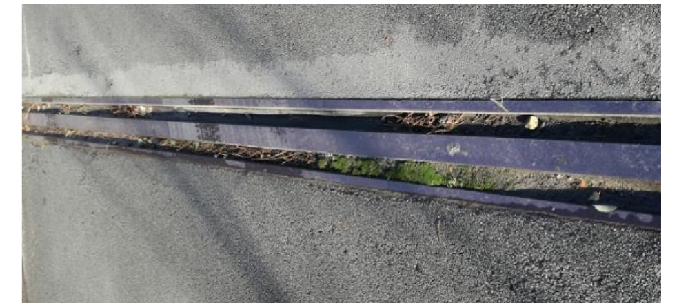
Figuur 5: Aanzanding voegband
