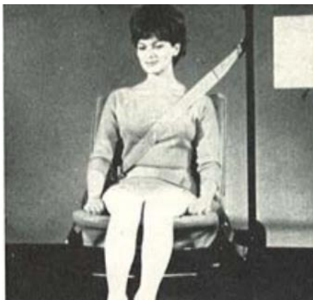
FIGUUR 3 Demonstratie van een combined lap and chest restraint tijdens het dynamisch testen (40 km/h), 100 ms na impact (Aldman, 1962)
