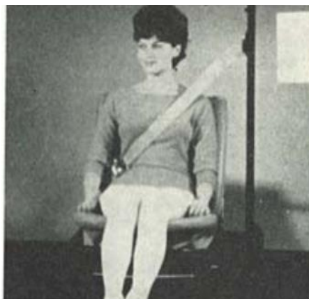
FIGUUR 3 Demonstratie van een combined lap and chest restraint tijdens het dynamisch testen (40 km/h), 100 ms na impact (Aldman, 1962)
