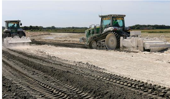
Figuur 2: Grondbehandeling met het bindmiddel kalk [5]
