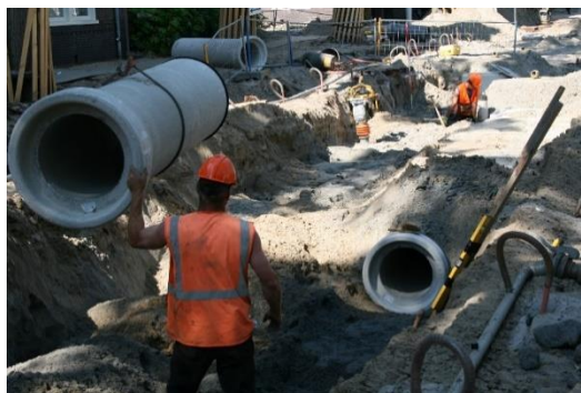
Figuur 1: De aanleg van een rioleringsbuis [3]
