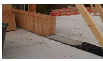
Figuur 3: Plaatsing akoestische muurstrook[4]
