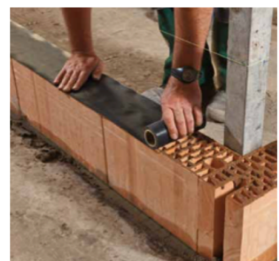
Figuur 2: Plaatsing waterkerende laag [2]
