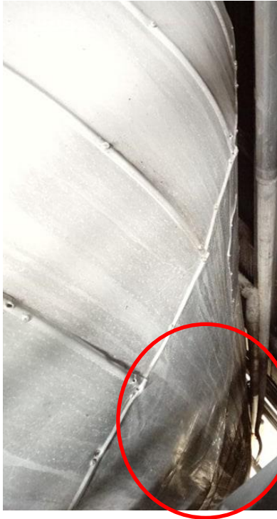
Figuur 21: Deuk in fermentatietank 4
