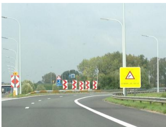
Figuur 5 Niet-conforme signalisatie: Signalisatie op verkeerswisselaars (Agentschap Wegen en Verkeer)
