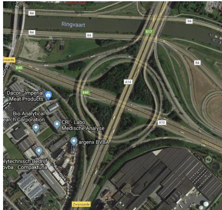
Figuur 25 Verkeerswisselaar: Zwijnaarde (Google Maps)
