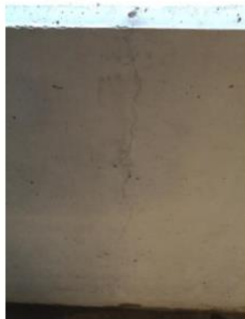
Figuur 26: Voorbeeld van een grote scheur [20, p. 33]
