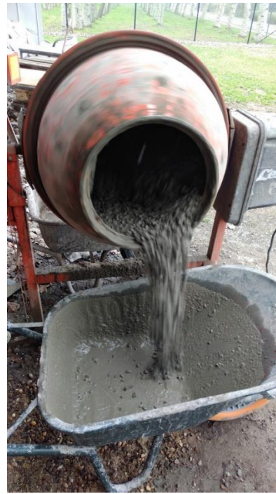
Figuur 50: Legen van betonmolen
