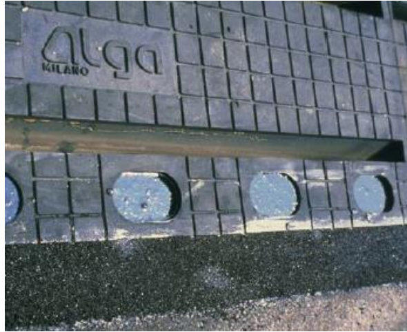
Figuur 19: Aanzicht gewapende mattenvoeg [1, p. 97]
