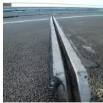
Figuur 3: Aanzicht traditioneel in de constructie verankerd klauwprofiel principe 1 [5]
