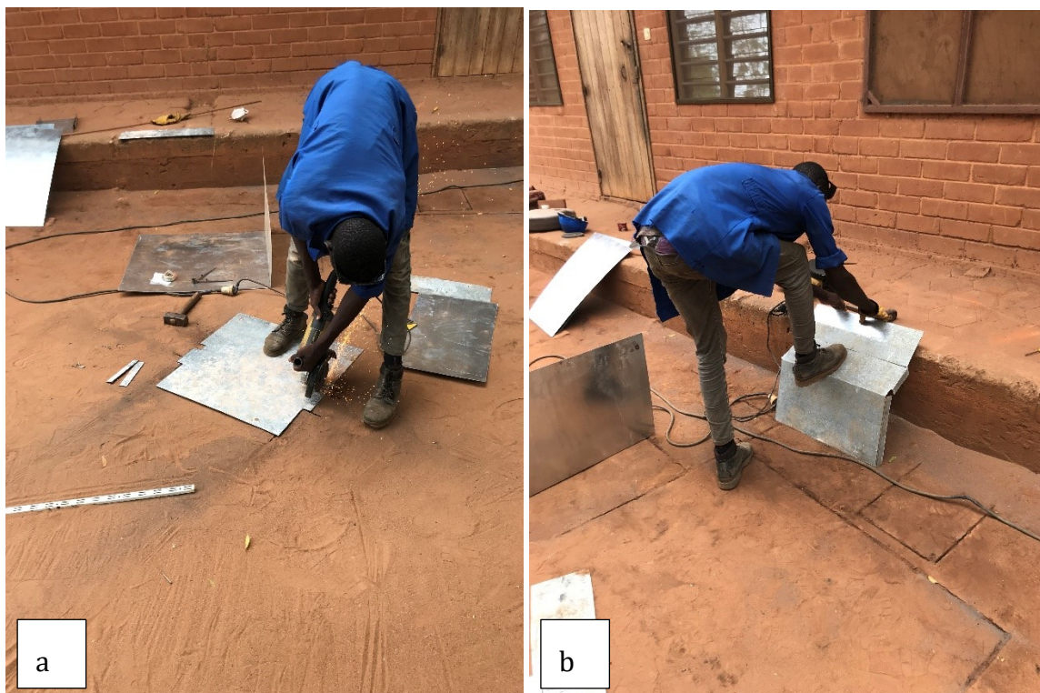
Figuur 40: Plaatmateriaal uitsnijden (a) en glijbaan plooiën (b)
