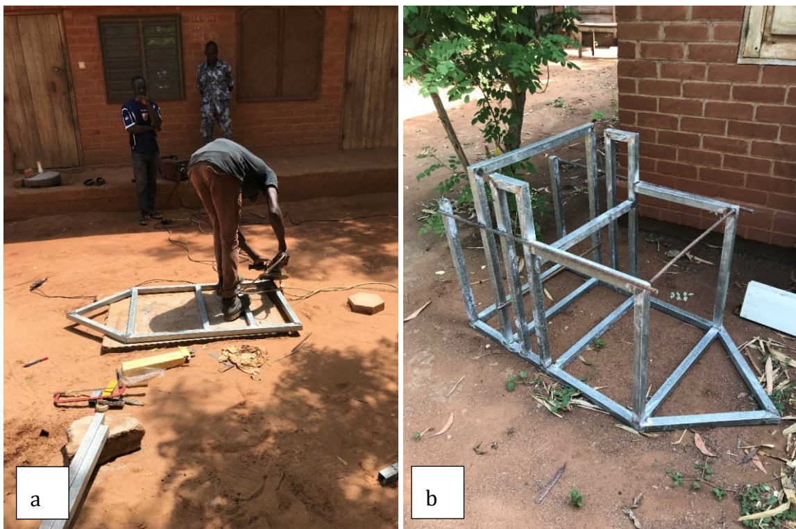
Figuur 42: Lassen van het frame (a) en frame geassembleerd (b)
