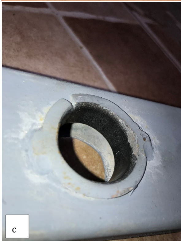
Figuur 32: Platen en frames verven (a), binnenkant glijlager met verf (b), glijlager proper gemaakt (c), binnenkant glijlager te hard aangetast (d)
