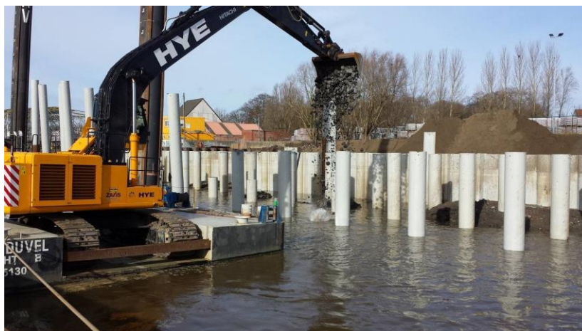
Figuur 39: Verlaagd dek in ponton Waterduvel [1]
