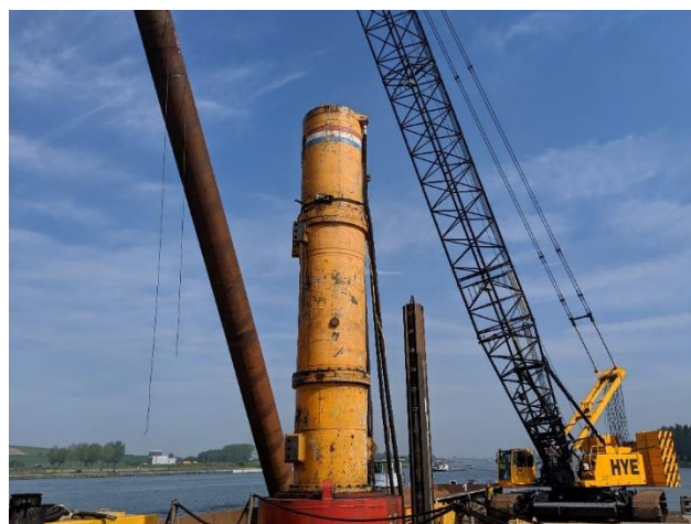
Figuur 43: Voorbeeld extra deklast - heihamer van 23 ton
