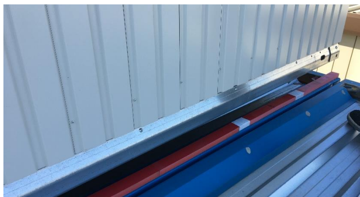
Figuur 31: Plaatsing CDM-strips tussen de opleggingen
