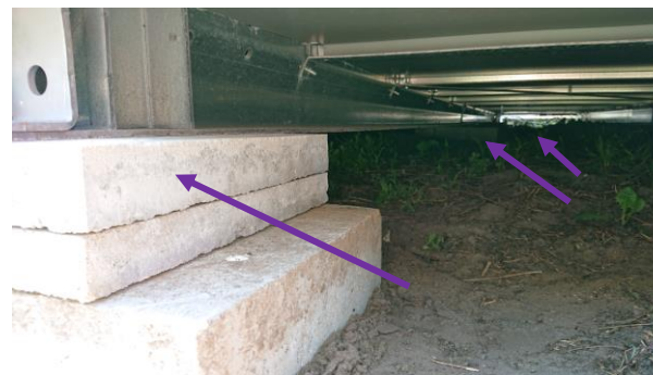
Figuur 3: Horizontale bout-moer-koppeling aan de uiteinden van de onderzijde (twee in totaal, waarvan één zichtbaar in afbeelding links) met ondersteuning op drie plaatsen door betontegels (zie drie pijlen in afbeelding rechts)
