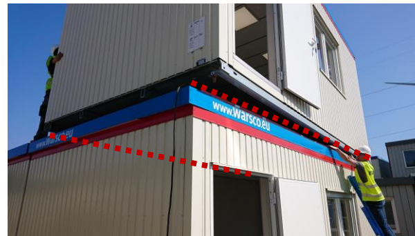
Figuur 2: Afbeelding van de stroken en montage tussen de units (aangeduid door rode stippellijn)
