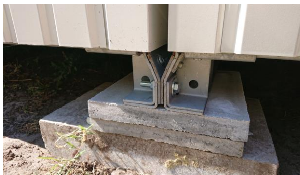
Figuur 3: Horizontale bout-moer-koppeling aan de uiteinden van de onderzijde (twee in totaal, waarvan één zichtbaar in afbeelding links) met ondersteuning op drie plaatsen door betontegels (zie drie pijlen in afbeelding rechts)
