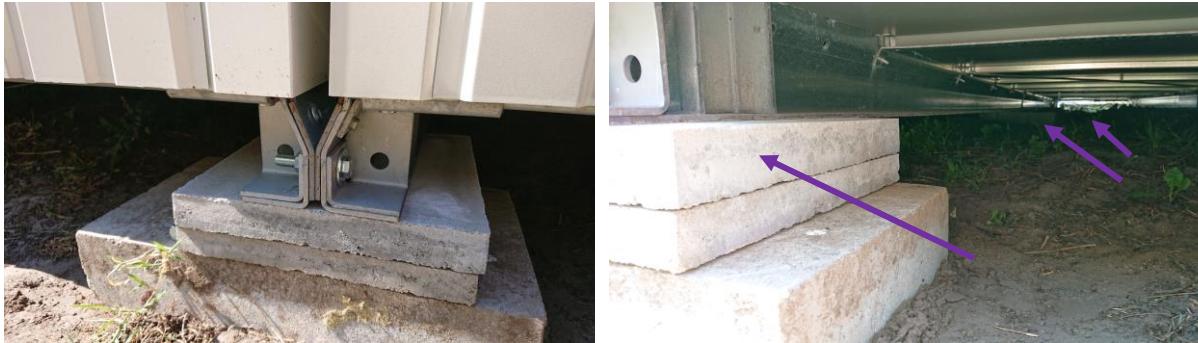
Figuur 3: Horizontale bout-moer-koppeling aan de uiteinden van de onderzijde (twee in totaal, waarvan één zichtbaar in afbeelding links) met ondersteuning op drie plaatsen door betontegels (zie drie pijlen in afbeelding rechts)
