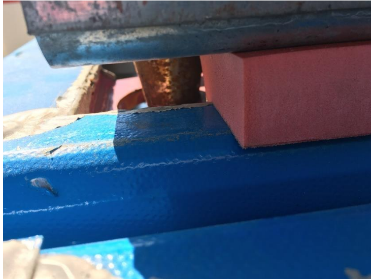
Figuur 32: Centreerpennen en hijs-oog van de unit
