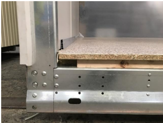
Figuur 14: Connectie langspijl met hoekprofiel
