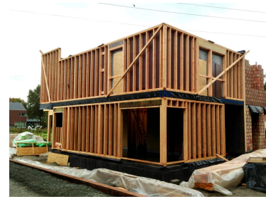
(c) Plaatsing op de werf
