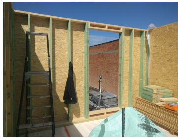
(b) Plaatsing wand op de werf
