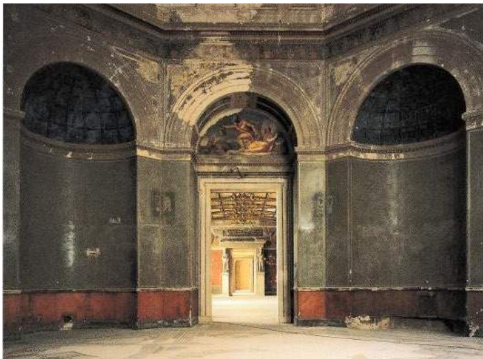
Figuur 26: Foto van de koepel voor de renovatie
