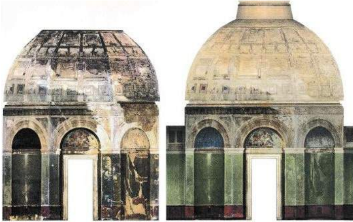
Figuur 25: De koepel voor en na de renovatie
