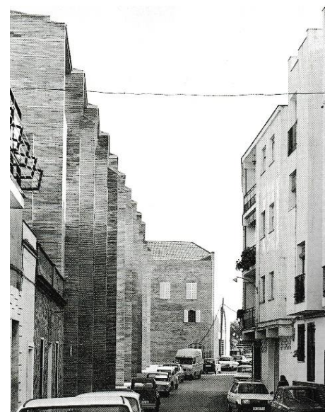
Figuur 53. Straatbeeld. Overgenomen uit Rafael Moneo 1995 2000 door El Croquis, 2000, Madrid: El Croquis Editorial. Copyright 2000, Uitgeverij El Croquis Editorial
