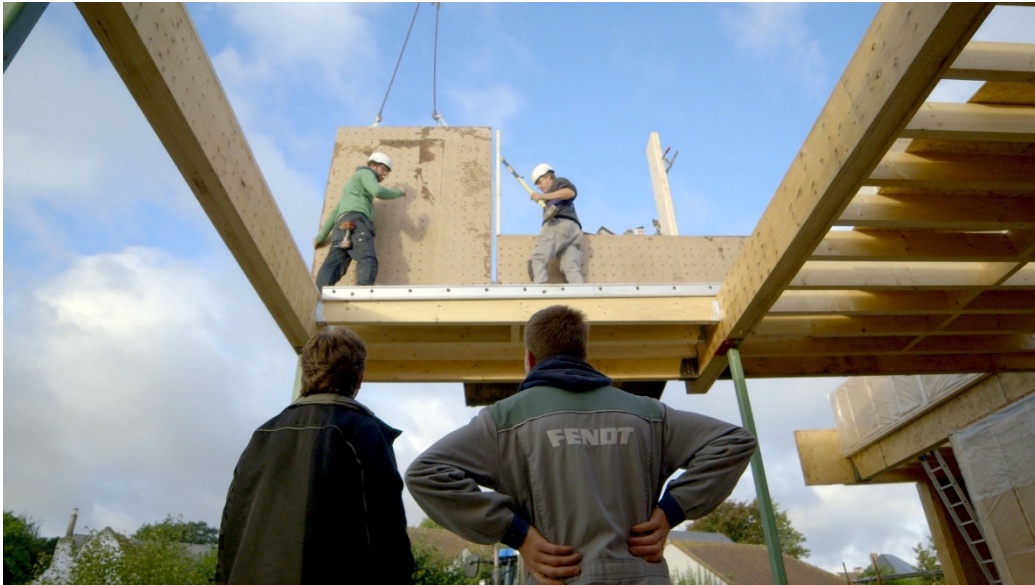
Figuur 6-4: Bevestiging kalkhenneppanelen (PUUR-bouwen 2016)
