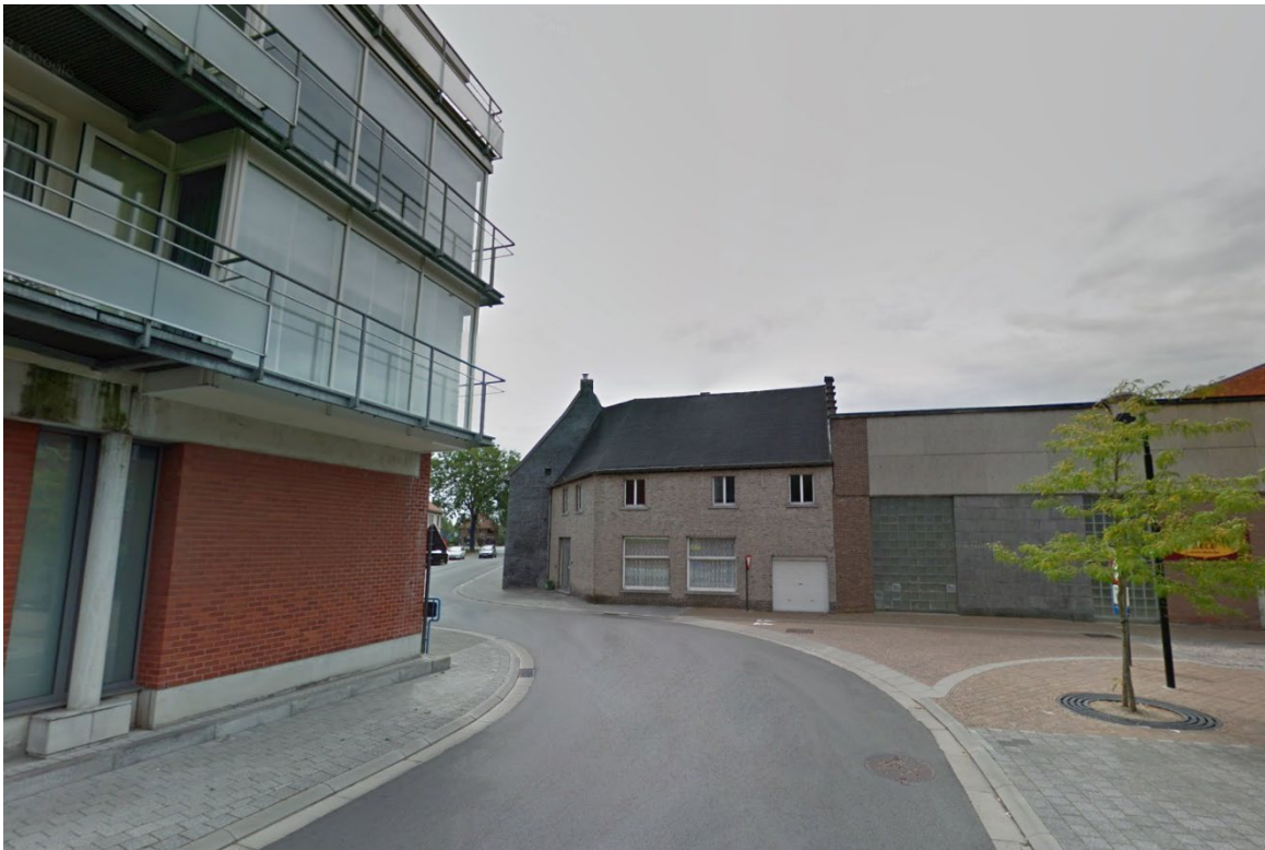
Figuur 4-2: Bestaande woning (Google Street view)
