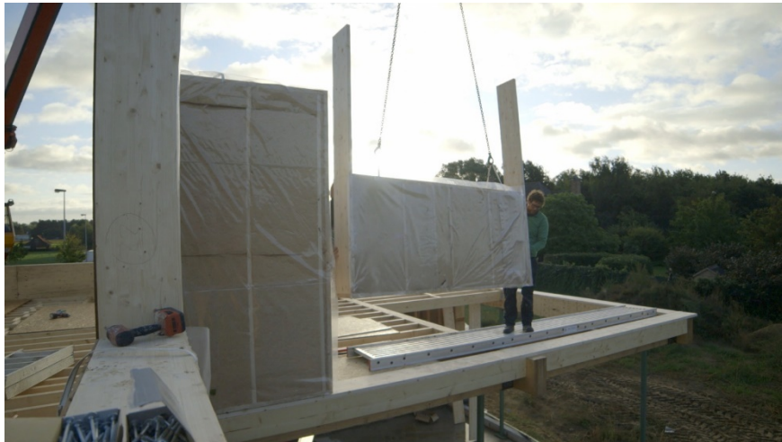
Figuur 3-11: Plaatsing van kalkhennep prefab wanden (PUUR-bouwen z.d.)
