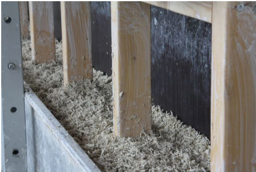
Figuur 3-4: Kalkhennep toegepast met houtskeletbouw (huis 2018)
