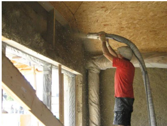
Figuur 3-8: Aanbrengen van kalkhennep d.m.v. spuitmachine (Energieprovincie 2017)
