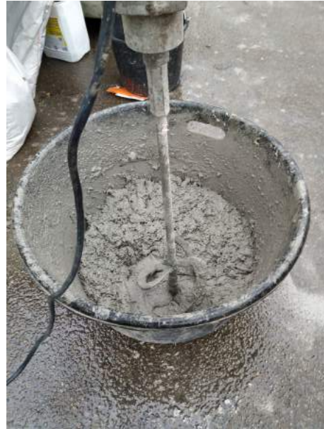
Figuur 5.4: Menging van betonspecie
