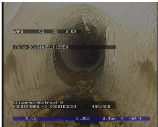
Figuur 1.3: Vervorming van de rioolbuis[7]
