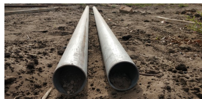
Figuur 4: de buizen voor de toren
