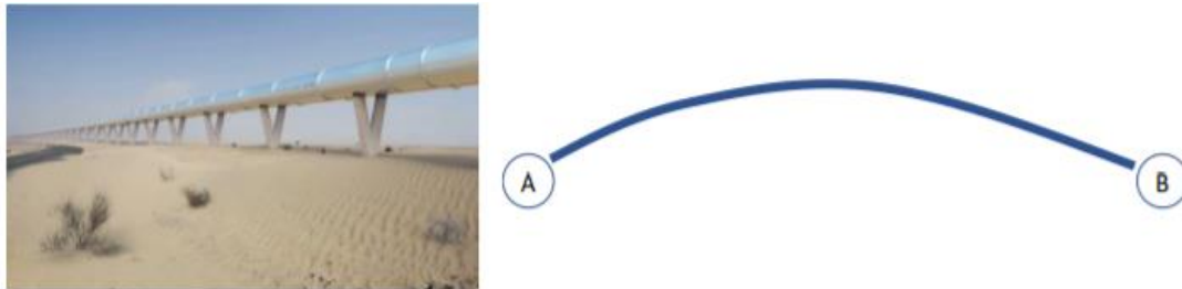
Figuur 17 Beperkte flexibiliteit bij hyperloopverbindingen (Doppelbauer, 2018).
