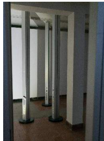
Afbeelding 19: Stopcontact en elektriciteit ingebouwd (Rotor, 2020).
