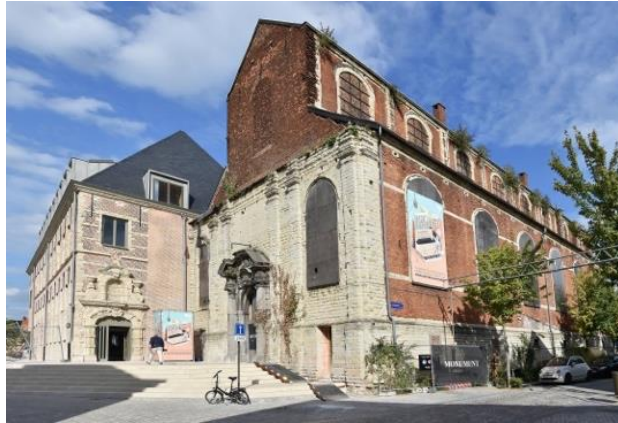
IMAGE 20 HET PREDIKHEREN CHURCH - EXTERIOR
