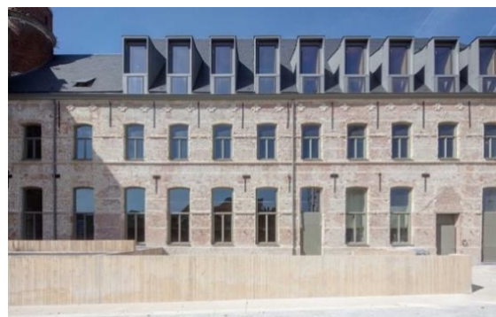
IMAGE 18 HET PREDIKHEREN RESTORED FACADE
