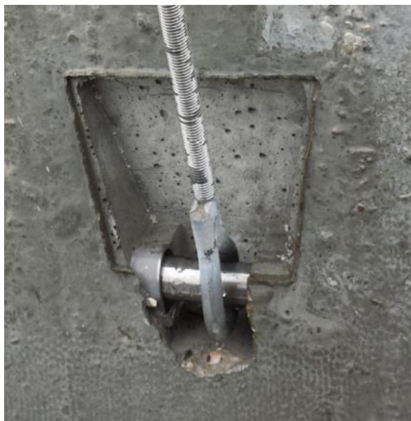
Figuur 30: Inbouwdeel gevelplaatanker Fixinox [26]
