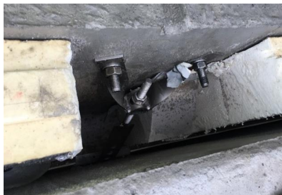
Figuur 10: Ontdubbeld gevelplaatanker (bovenaan foto: draagstructuur – onderaan foto: PBGP)
