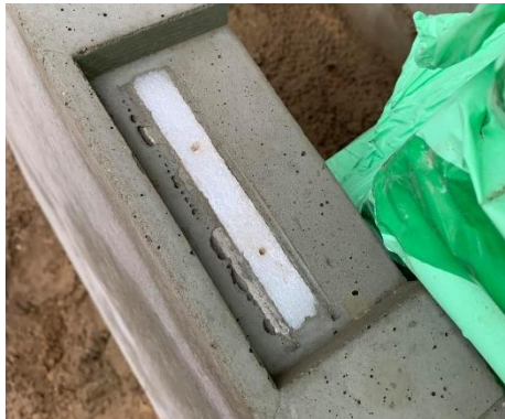
Figuur 25: Ankerrail in uitsparing voor L-profiel
