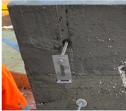
Figuur 22: Windanker aan PBGP tijdens montage
