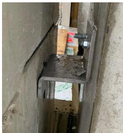
Figuur 27: Z-profiel met verticale ankerrail in PBGP
