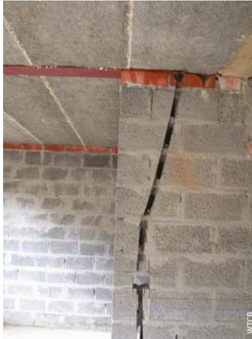
FIGUUR 2.5: ONTOELAATBARE VERZWAKKING – SLEUF [10, p. 109]
