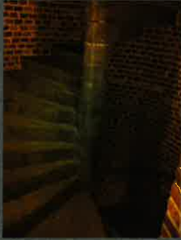
Afbeelding 168. Eigen foto: centrale betonnen spiltrap
