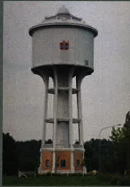
Afbeelding 28. Betonnen watertoren in Leper uit 1921
