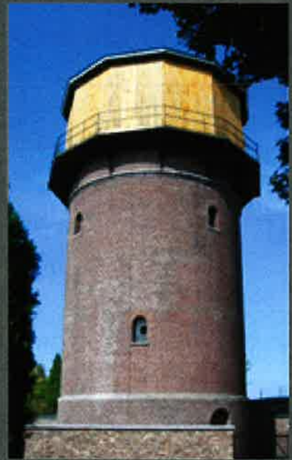
Afbeelding 14. Watertoren van Tongeren bekleed met houten lattenwerk uit 1903
