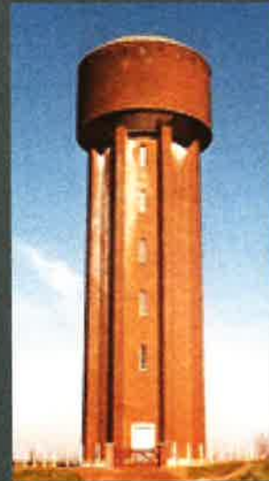
Afbeelding 31. Watertoren met steunberen te Borgworm uit 1949
