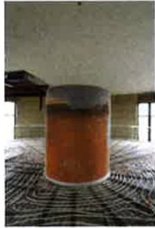
Afbeelding 146. Aanleg vloerverwarming keuken en leefruimte
