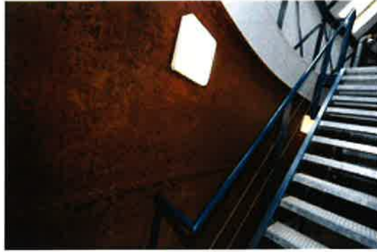
Afbeelding 116. Eigen foto: Verroeste stalen kuip
