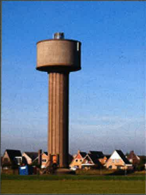
Afbeelding 27. Betonnen watertoren in Nes (Nederland) uit 1957
