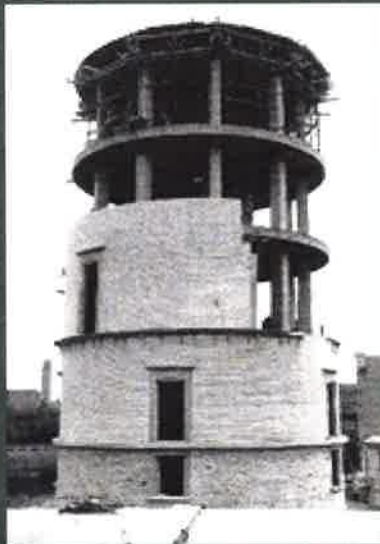
Afbeelding 30. Watertoren met betonnen dragende kolommen en niet dragende mantel in Tiel uit 1956
