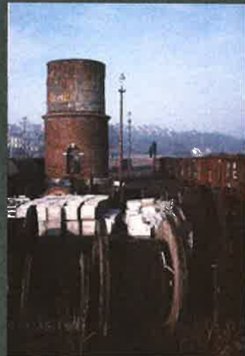
Afbeelding 11. Watertoren met ijzeren hangbodemkuip aan het station van Namen uit 1931
