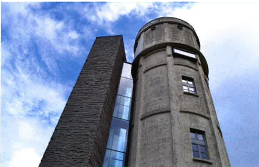
Afbeelding 177. Herbestemde watertoren met circulatiekoker te Lembeek
