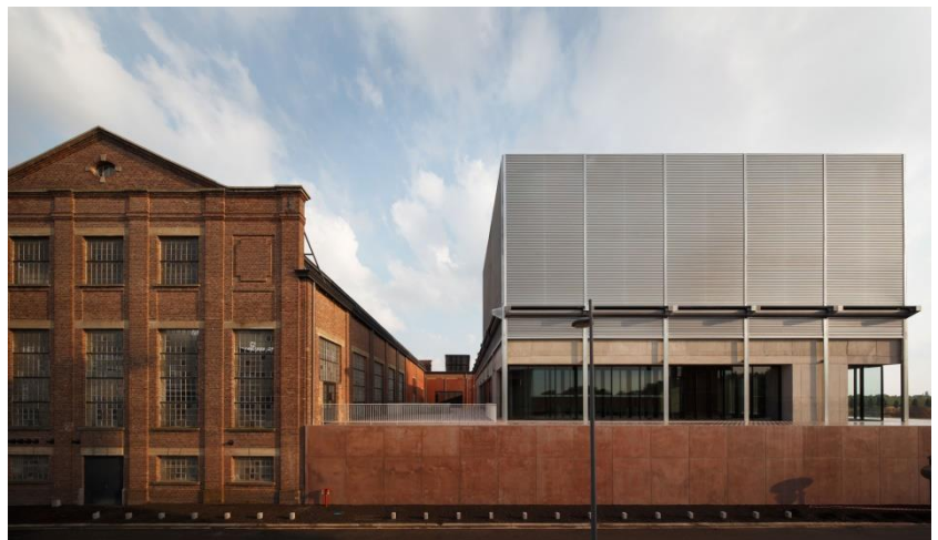
Fig. 47 Betonnen sokkel C-mine: contrasterend materiaal in analoge kleur
