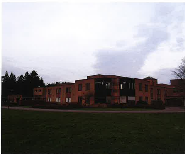
Afb. 99 en 100 Nieuwbouw in 1992 voor respiratoire afdeling
