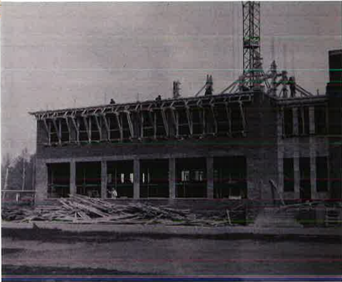
Afb. 90 Nieuwbouw i.p.v. kuuroorden
