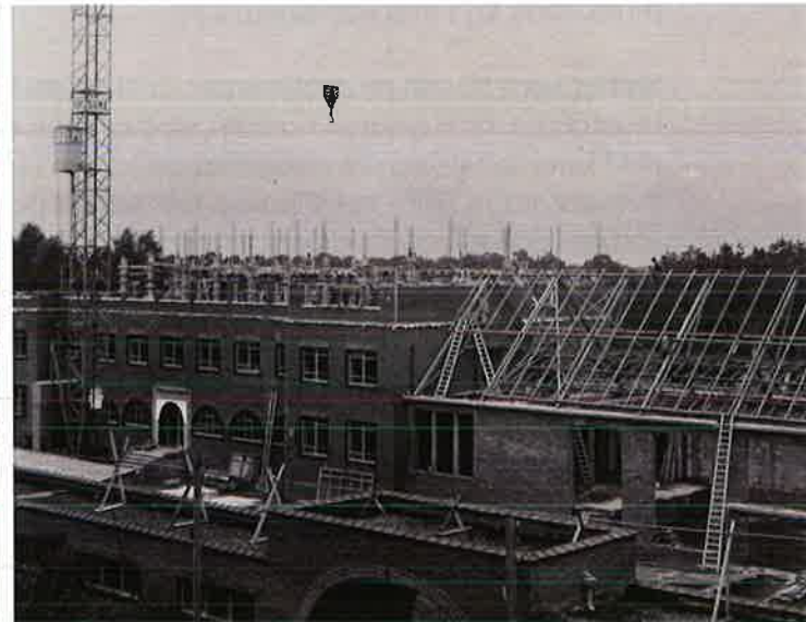
Afb. 95 Bouw wasserij, feetzaal en verdieping 2
