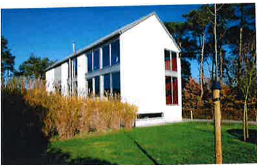
Figuur 27: Buitengevel uit YTONG in eerste fase (www.livios.be, z.j.)
