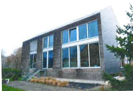
Figuur 28: Houten gevelbekleding zuidkant woning
