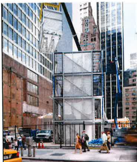
Figuur 10: Korte bouwtijd door modules (A. Vecerka/ESTO, z.j.)
