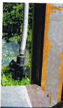
Figuur 50: Zichtbaar constructiedetail met bouten (Eerdesign, n.d.)
