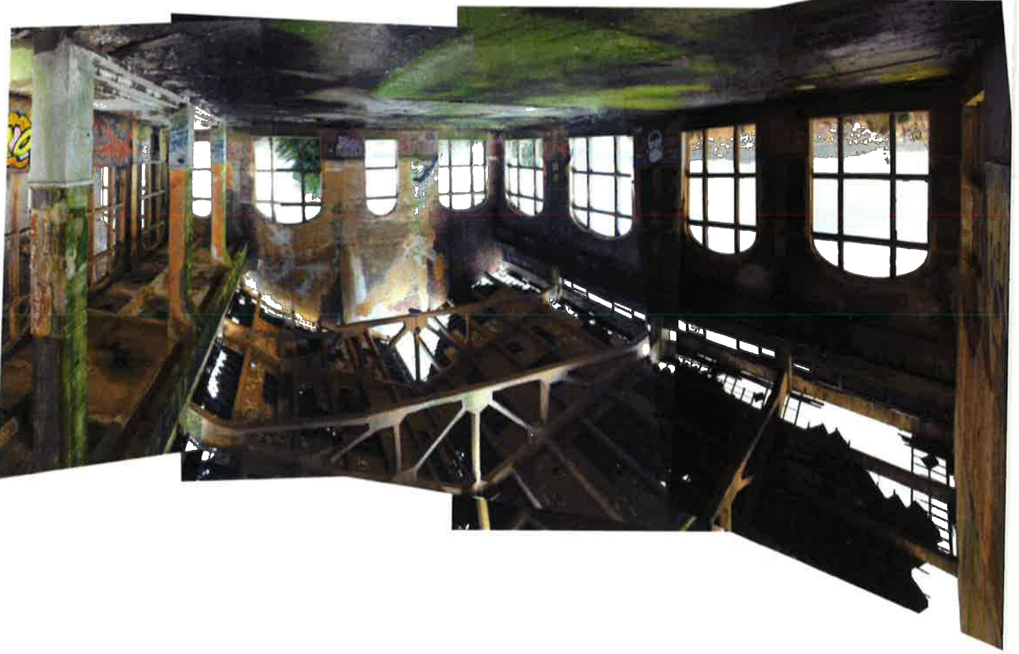
Arbeiding 48 Interieur extractiegebouw
