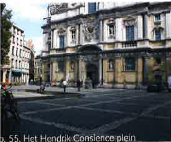
4 Hendrik Conscience plein, het plein is ontstaan door de overwelving van de Jezuïetenruï omstreeks 1620. De Carolus Borromeus kerk werd op deze overwelfde Ruïen gebouwd, ca. 1614-1627 (AOE, 2016: 1). De overwelving is uitgevoerd in witte natuursteen, de bestrating werd door Aquafin vervangen door een zacht beton in plaats van kasseien.
