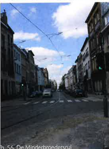
5 De Minderbroedersruï. Op deze plaats wordt de ruï voorzien van een schuif, de schuif van Manneken Door. De Ruïen werden voorzien van enkele schuiven, enkel deze is nog aanwezig. Onder een putdeksel bevindt zich de schroefstang voor het openen van de schuif. De schuiven hadden erg typerende namen: Manneken Door, Sjef Cognac en Advocaat. Ze verwezen naar wat er zich vroeger bovengronds bevond. Zo zou de schuif Sjef Cognac verwijzen naar de bovenliggende kroeg. Manneken Door is afgeleid van de speelgoedwinkel die Au Mannequin d'Or noemde. Advocaat zou verwijzen naar een bekende advocaat die boven de schuif woonde (Leemans, 2006: 64).
