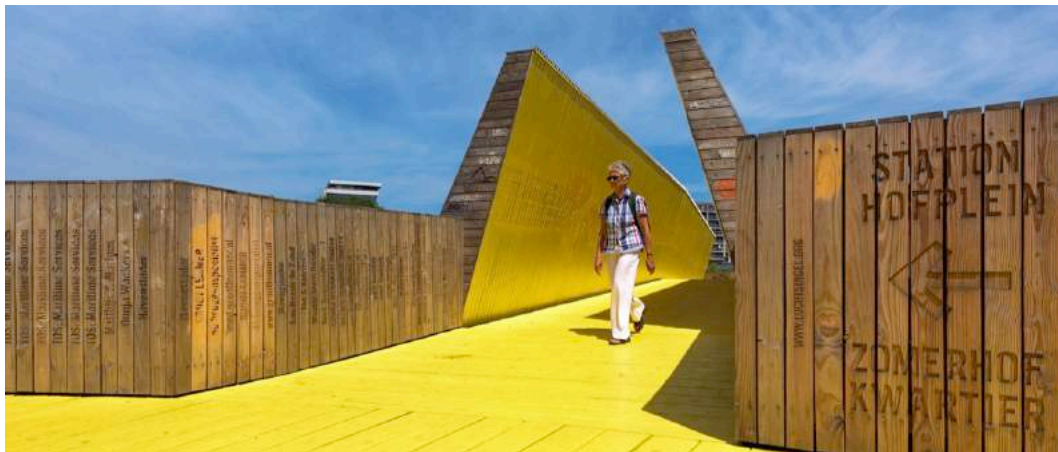
Afbeelding 11: De Luchtsingel in Rotterdam. Deze voetgangersbrug werd gecrowfund om een achterstaande buurt opnieuw verbinden met het stadscentrum. Men kon een deeltje (plank) van de brug kopen en personaliseren. (Verwoerd, D.,2015)
