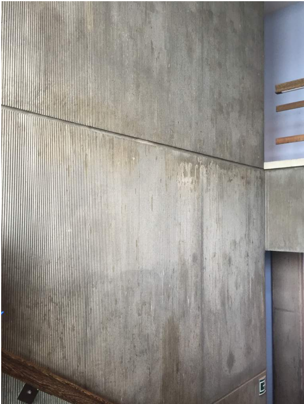
Afbeelding 60: Gegroefde beton in de centrale hal.
