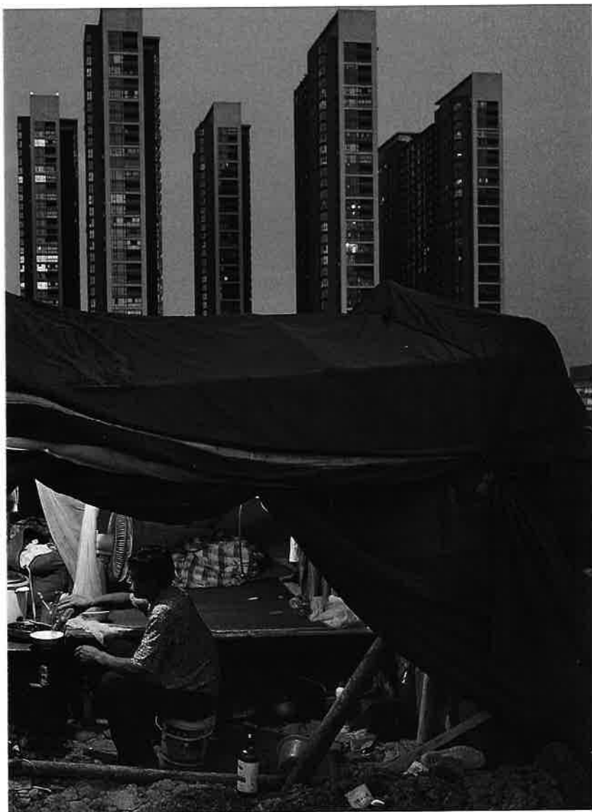
Afb. 30, Een arbeider die aan het dineren is op de werf van een residentieel complex, Hefei, China (08.02.2012)
