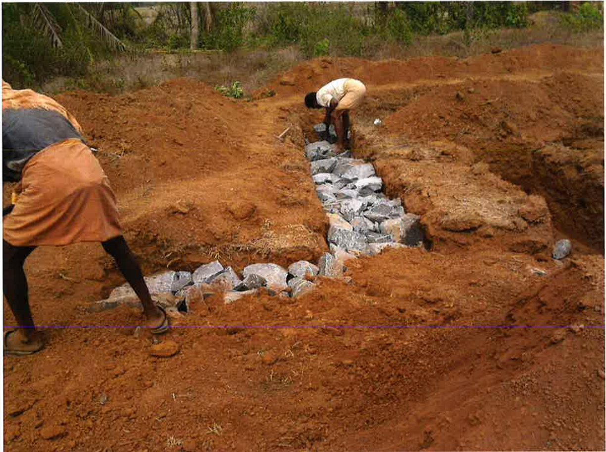
Figuur 60: Uitvoering van een Rubble Trench Fundering (Irshadpp, 2013)
