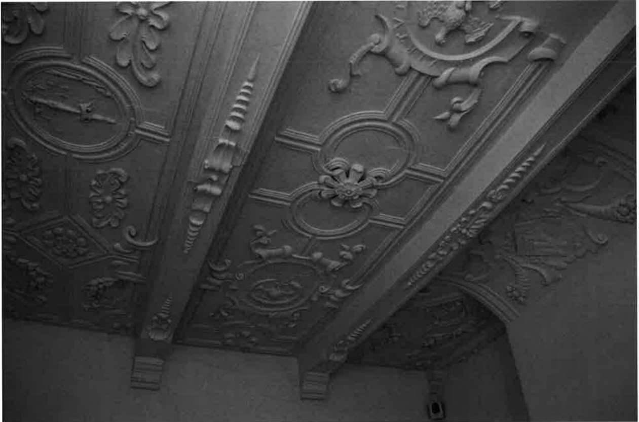
Afb 63: Stucwerk in de eerste emblematazaal
