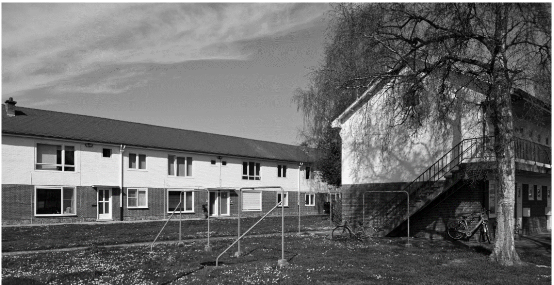
Figuur 3: Sociale woonwijk De Streyp in Mechelen (1956) vervaardigd uit rode baksteen onderaan en witgeschilderde baksteen bovenaan (Vandevorst, 2015).
