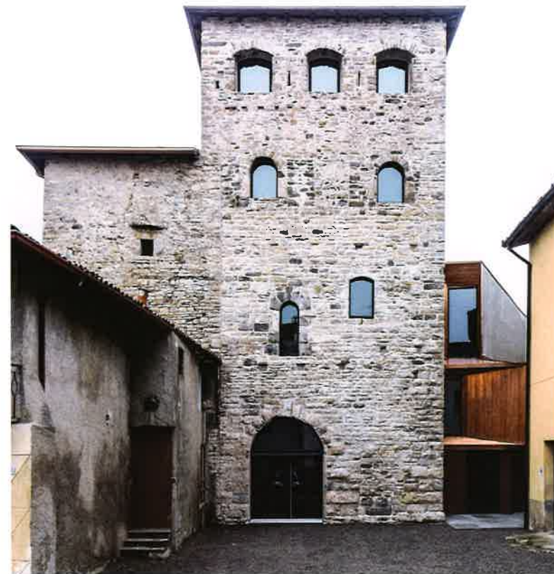
Fig. 56. Voorgevel Torre Del Borgo.
