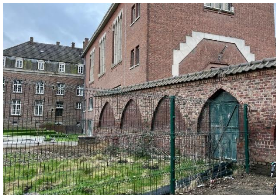
Figuur 30: bogen in muur tussen verharde speelplaats en kloostertuin
