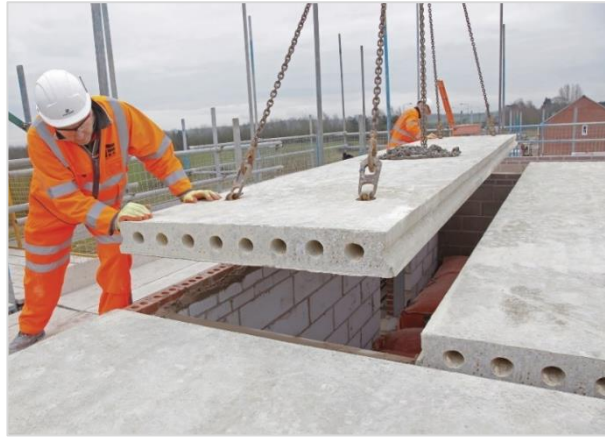
Figuur 2: Voorgespannen holle welfsels tijdens montage [5]
