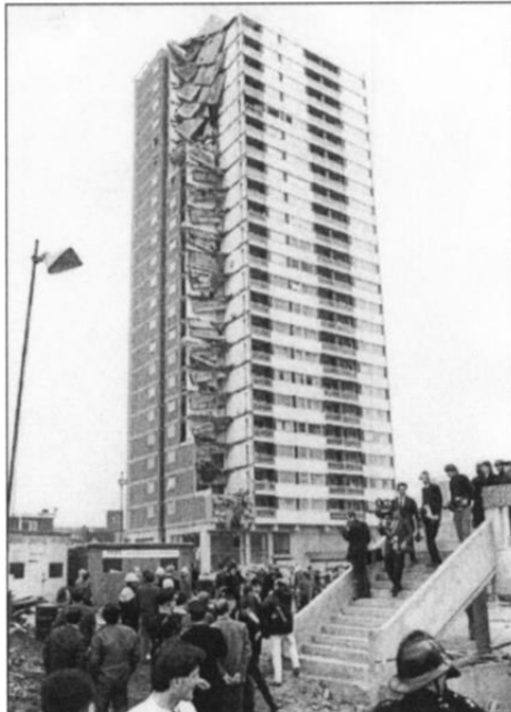
Figuur 1: Ronan Point appartementsgebouw [2]
