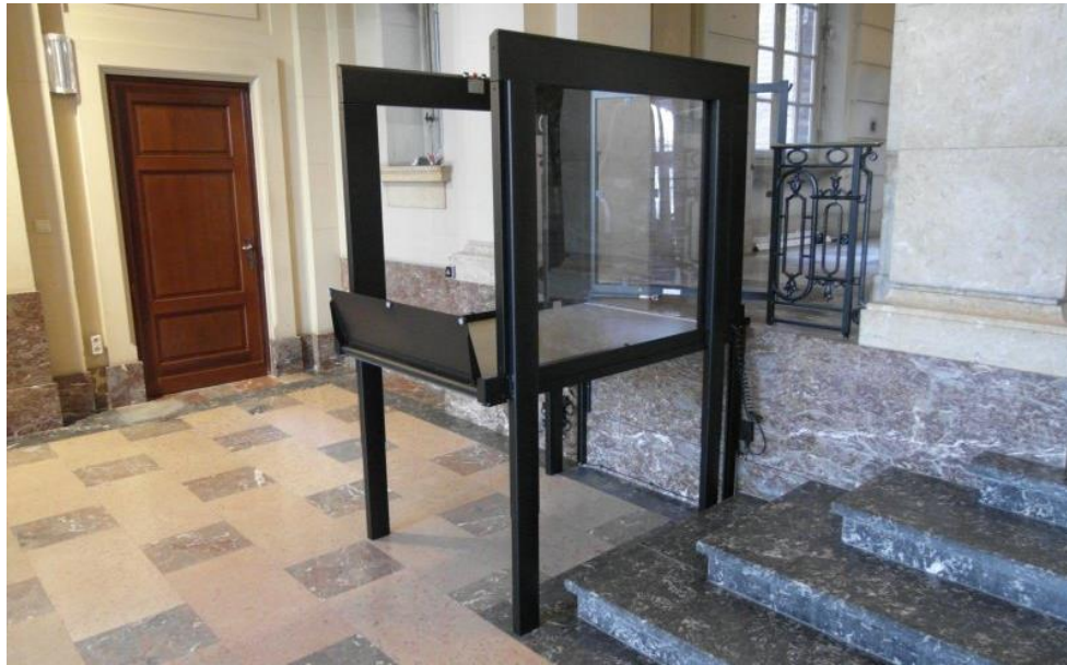
Figuur 18: Lift met enkel verticale beweging [1]
