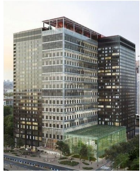
Figuur 13: Project "ZIN" na reconversie (Befimmo, 2020)
