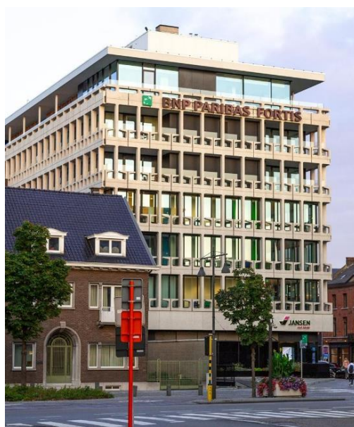
Figuur 9: Project “De Generale” na reconversie (Jansen Real Estate, 2021)
