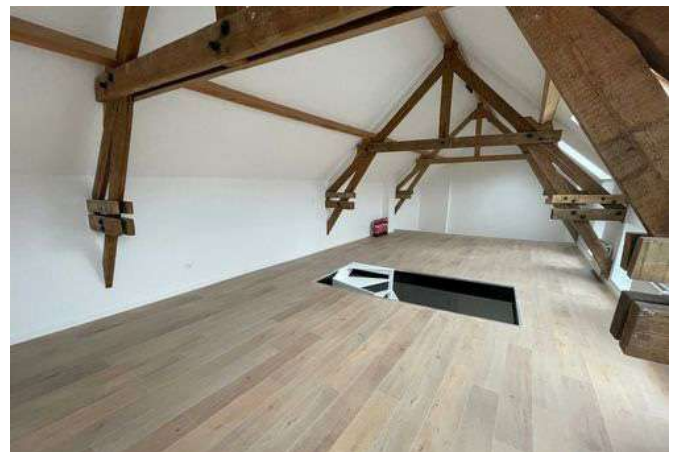
Afb. 45: Atelierruimte 2 (BVM Vastgoed, 2022)
